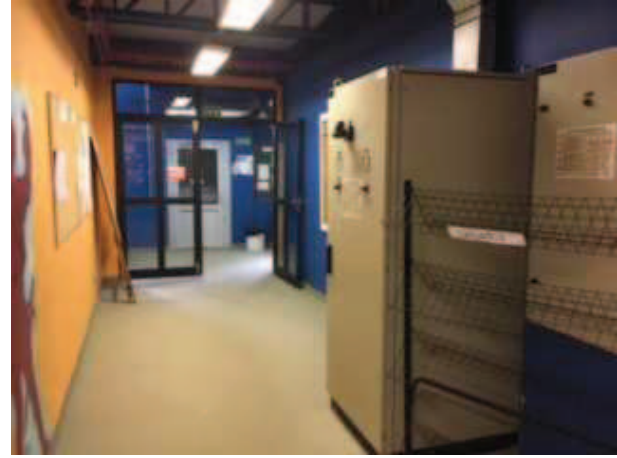
Foto 2 (Quadro Elétrico no corredor)
