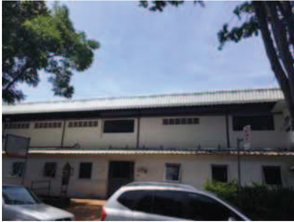
Foto 1 (Inexistência de SPDA)
