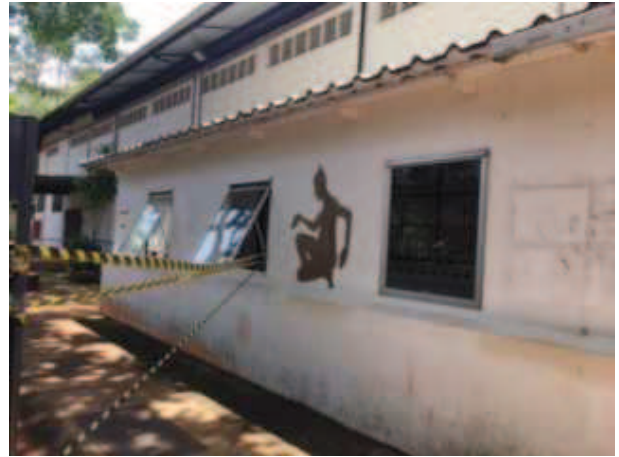
Foto 8 (Pintura do piso)
