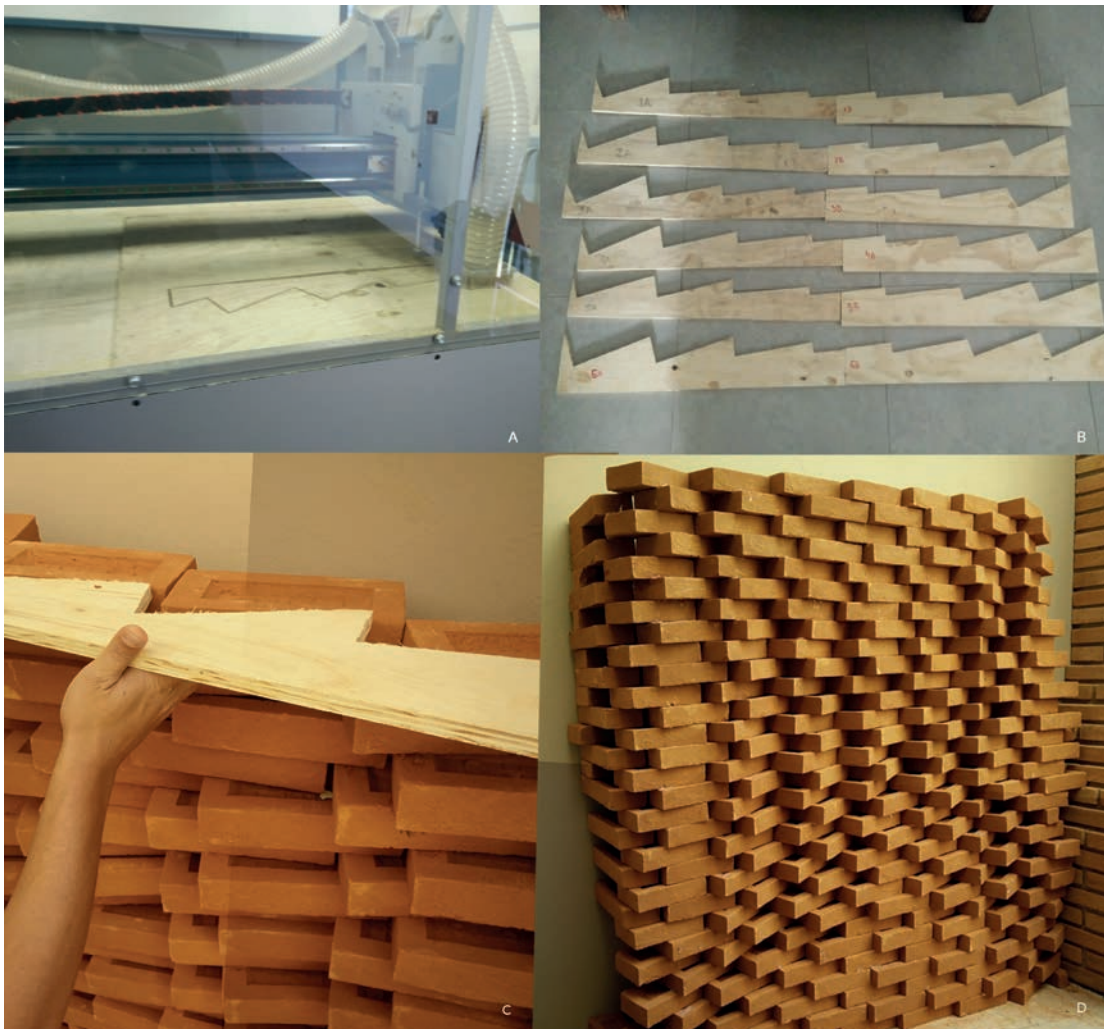
Fig 6. Fabricação dos gabaritos e assentamento dos blocos cerâmicos. Os 32 gabaritos foram cortados na CNC (A,B). Cada fiada utilizou composta por dois gabaritos como guia durante o assentamento dos blocos (C,D).
