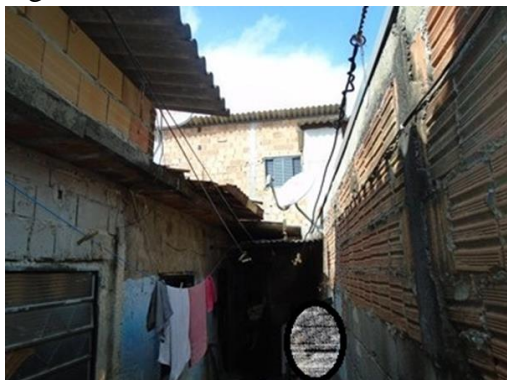
Figura 6 – Visitas realizadas. Casa na situação anterior à reforma.
