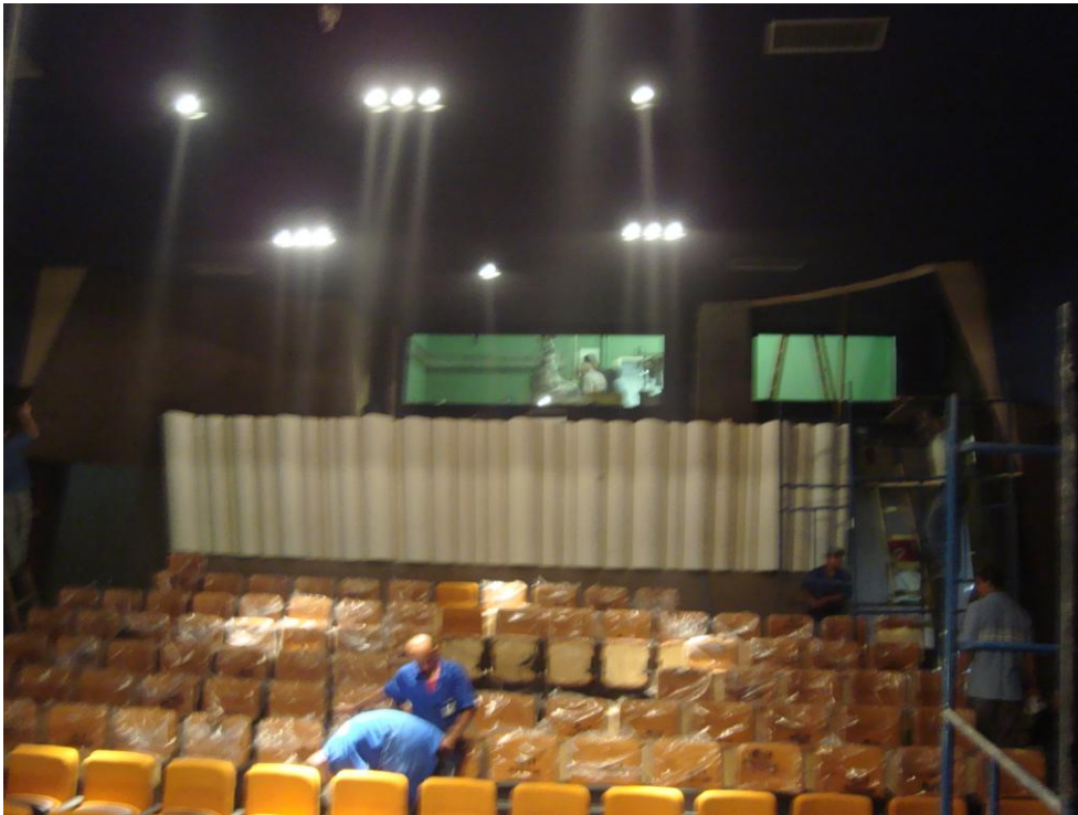
Superfície SCSS antes da pintura
