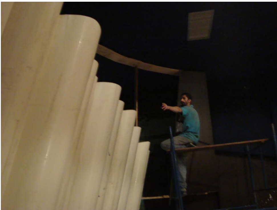
Montagem da Superfície SCSS ao fundo da platéia e dos rebatedores traseiros superiores.
