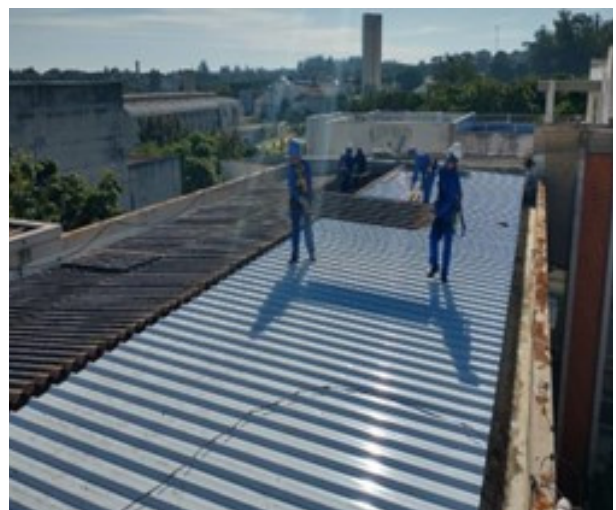
Obra em execução
